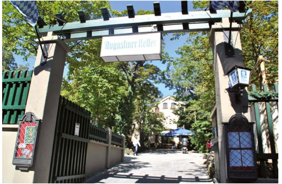
Eingangssäulen Sichtbeton verputzt
