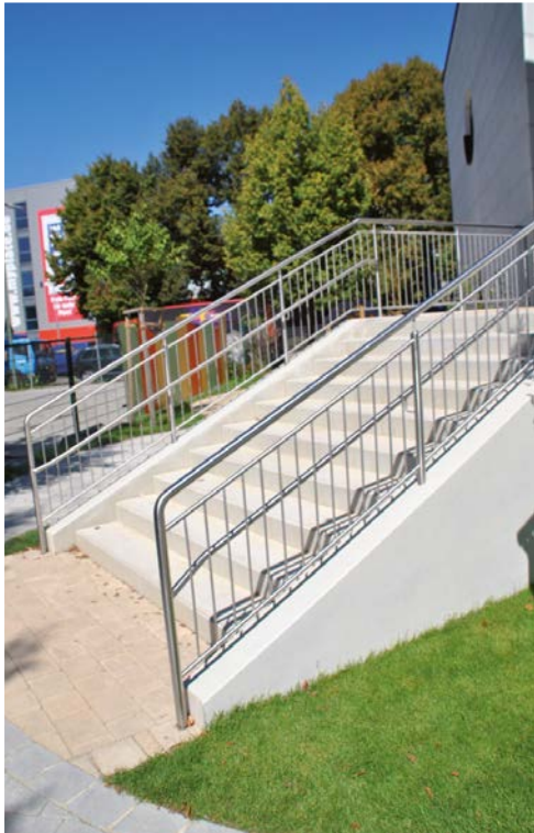
Treppenanlage Oberfläche rutschhemmend Betosieb
